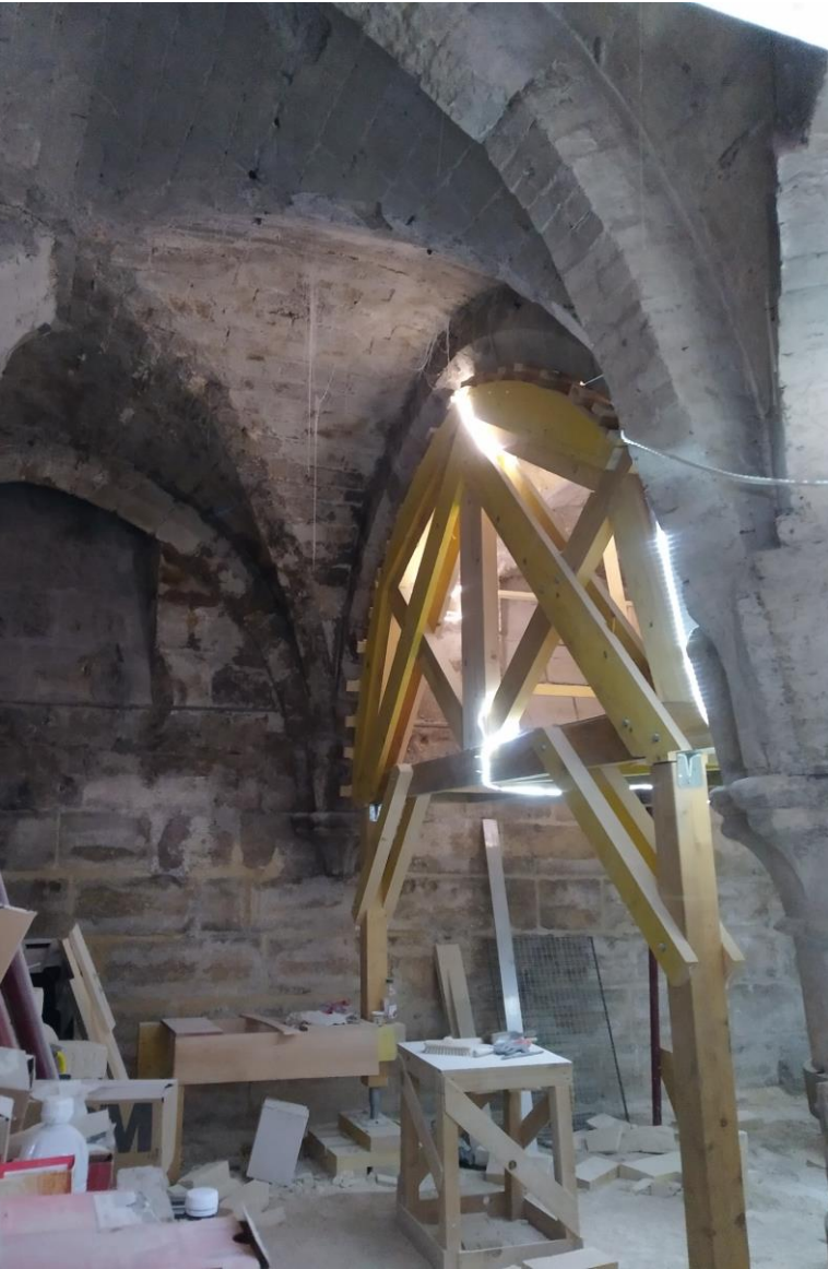
Etayage du chantier
