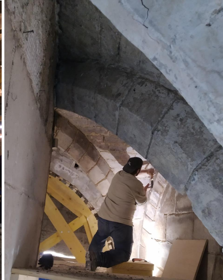
Tailleur de pierre en action sur le chantier
